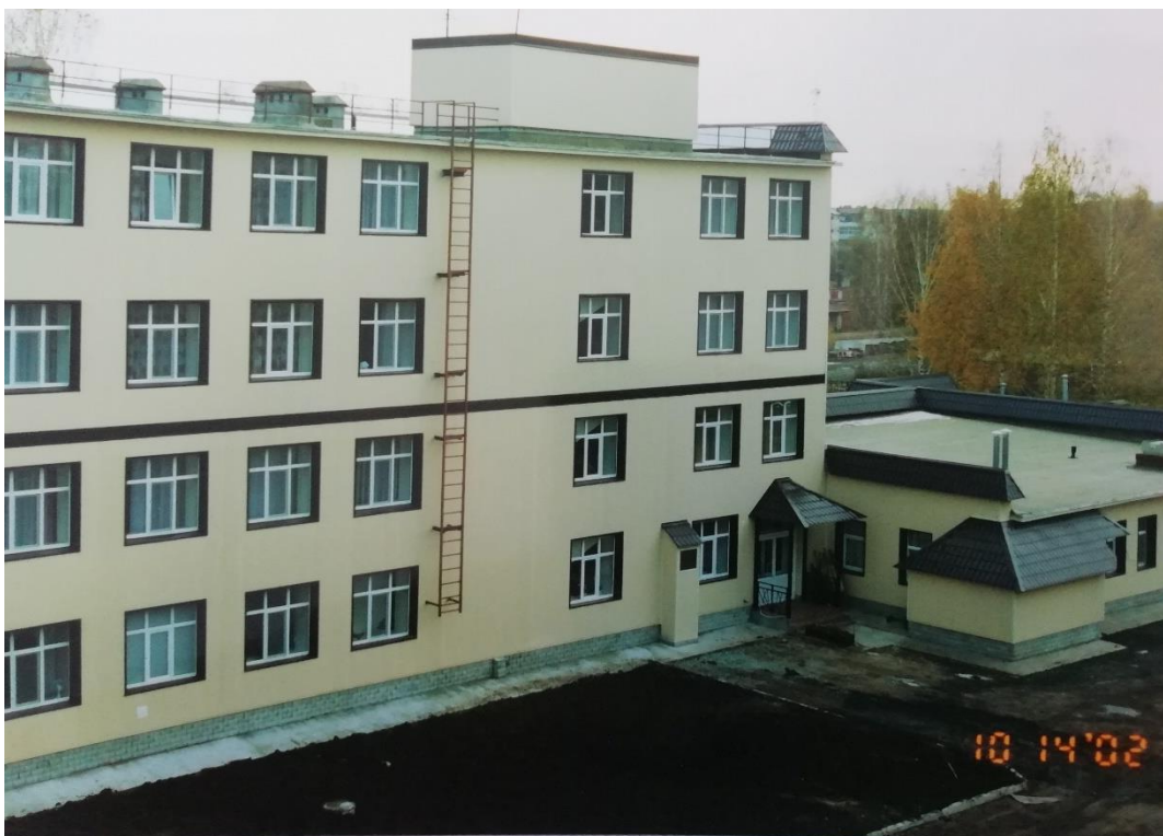
Окончание капитального ремонта 2002 год
