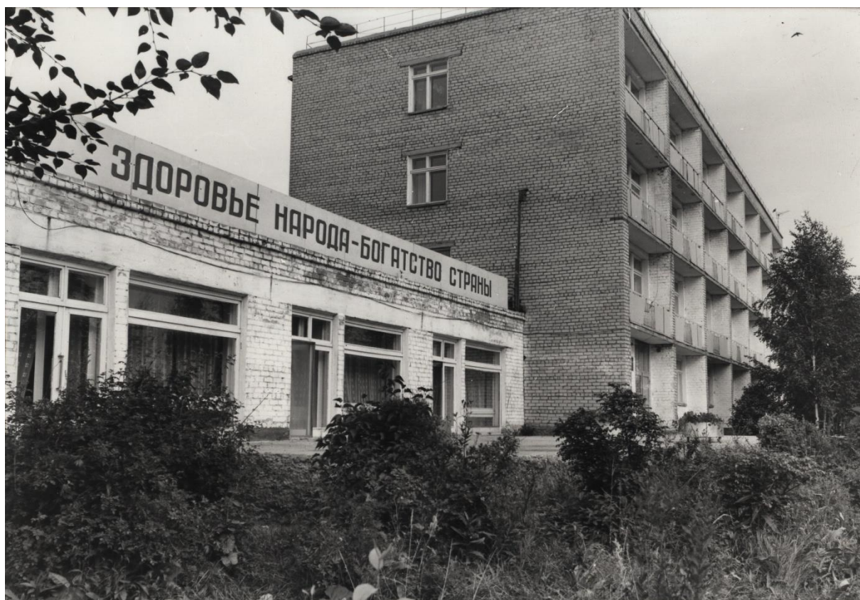
Идут работы по благоустройству территории
