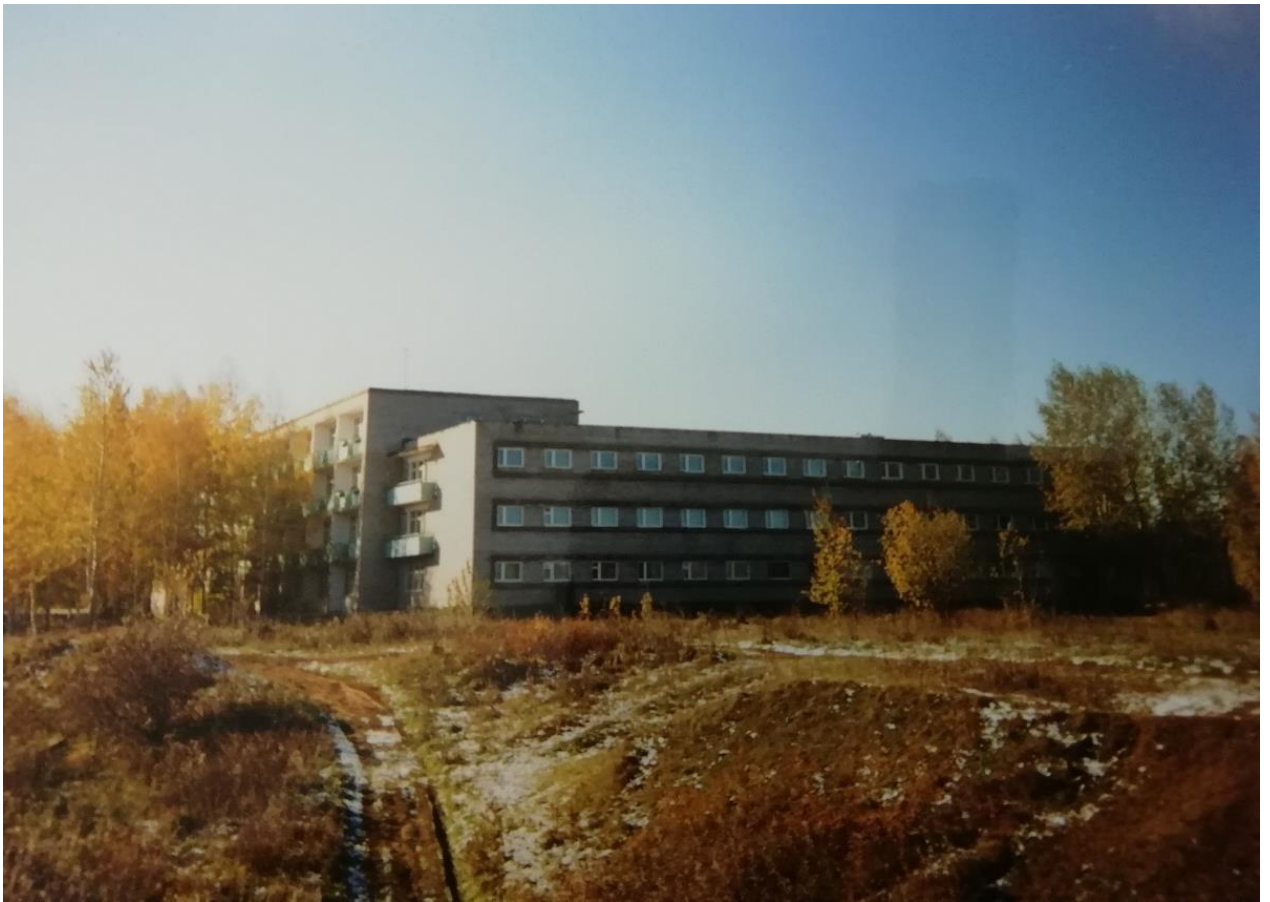
Здание до начала ремонтных работ по смене наружной отделки здания.
